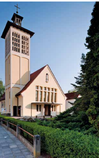
Kirche St. Marien Georg-August-Zinn-Straße/ Ecke Feldstraße, Dudenhofen
